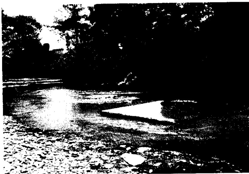
Element de beton deplasat de viitură
