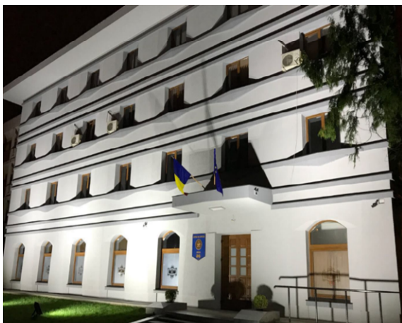
Sediul Camerei de Conturi Argeș
